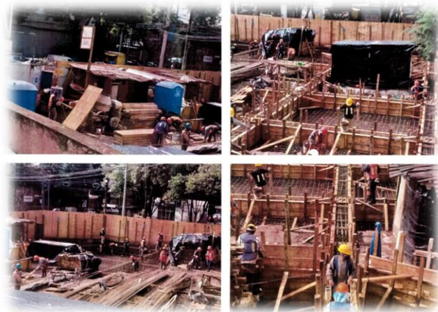
Avances en la construcción
