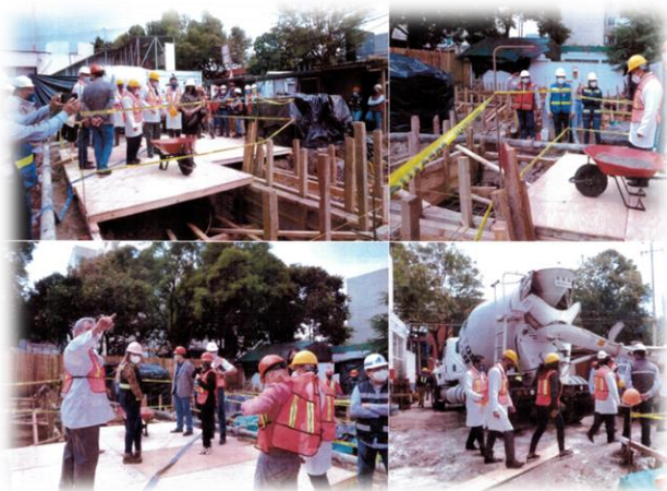
Trabajos para del primer colado
