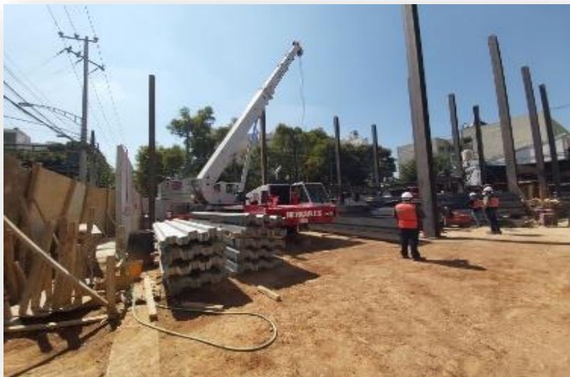
MONTAJE DE COLUMNAS DE ACERO
