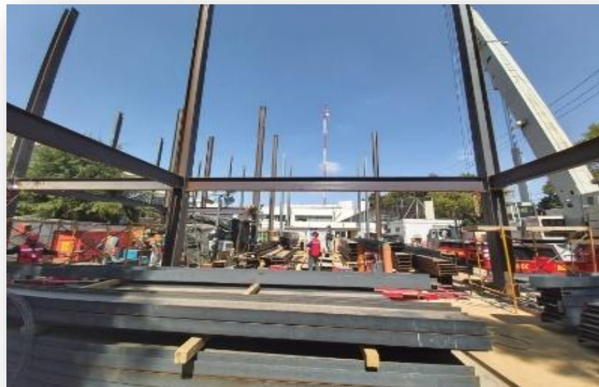
MONTAJE DE VIGAS DE ACERO
