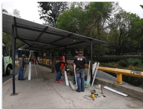
CETRAM CHAPULTEPEC Instalación de luminarias bajo cobertizo
