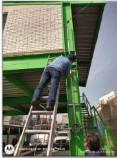
CETRAM TACUBAYA Revisión de conexión eléctrica
