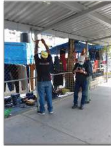
CETRAM MARTÍN CARRERA Revisión de reflector y alimentación eléctrica en andenes
